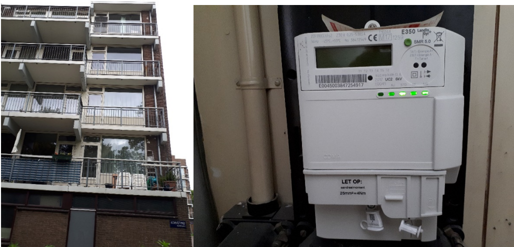
Figuur 6 – Balkons op het Korvetpad en kWh-meter met 1x30A aansluiting in de woning
