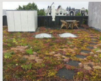
Extensief (sedum) dak
