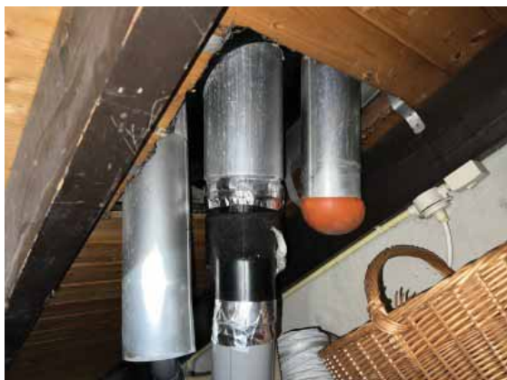
Doorvoer ventilatiebox afgekoppeld en afgedicht
